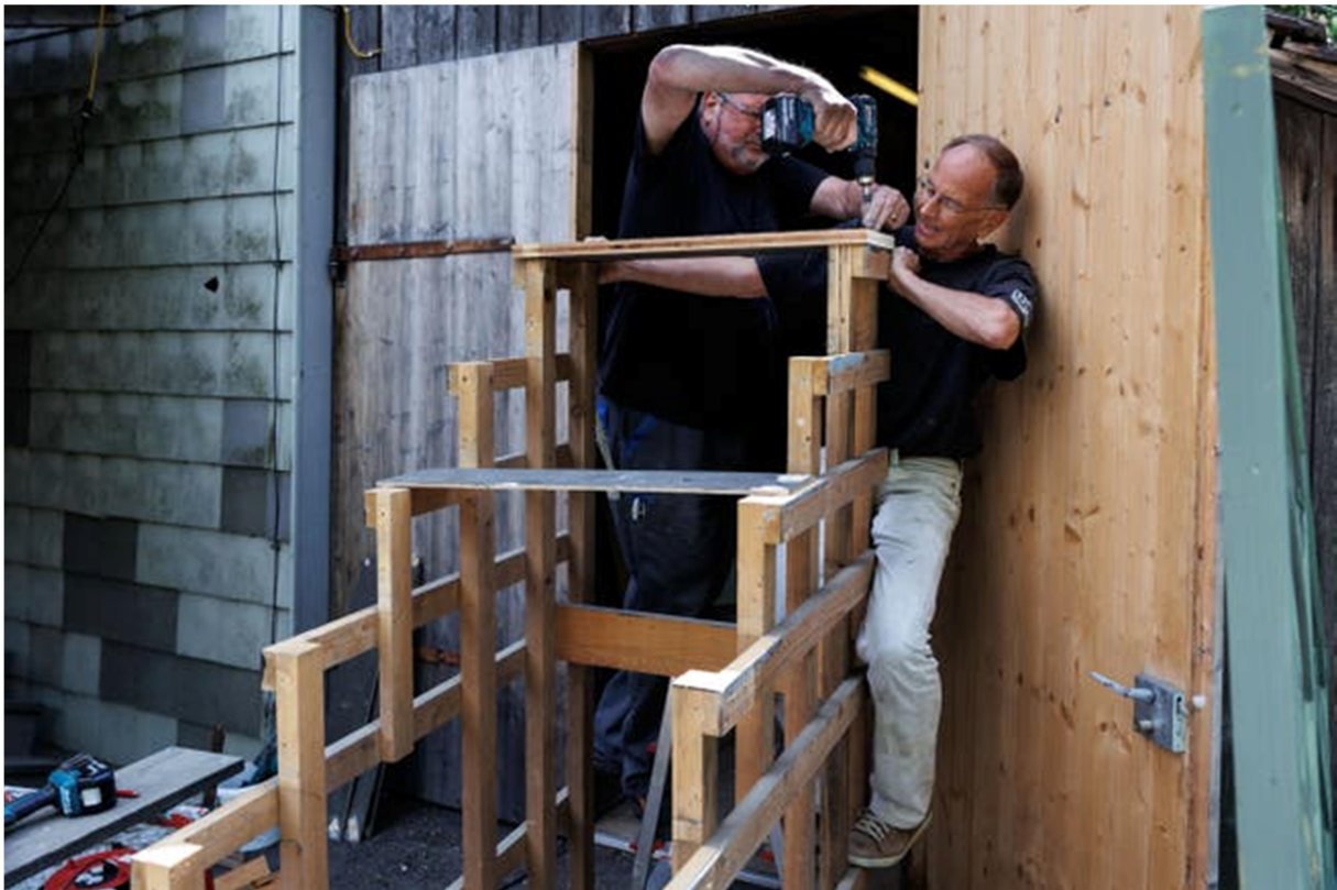
Aufbauarbeiten der Sommeroper Selzach.
